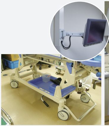
無痛大腸内視鏡検査を行う内視鏡室。検査の映像を患者が見やすいようにモニターの位置を自在に動かせるようアームを特注した。また、隣接する回復室に患者が寝たままベッドごと移動させるようにキャスターを付けた。これらは診療所のコンセプトを設計に活かした成果の一つ
